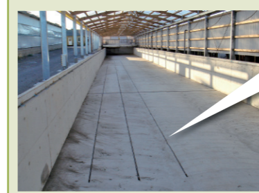
堆肥化を行う施設の床に目詰まりしにくい特殊なパイプを埋め込む。既存の配管との交換も可能
