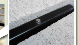
堆肥化を行う施設の床に目詰まりしにくい特殊なパイプを埋め込む。既存の配管との交換も可能
